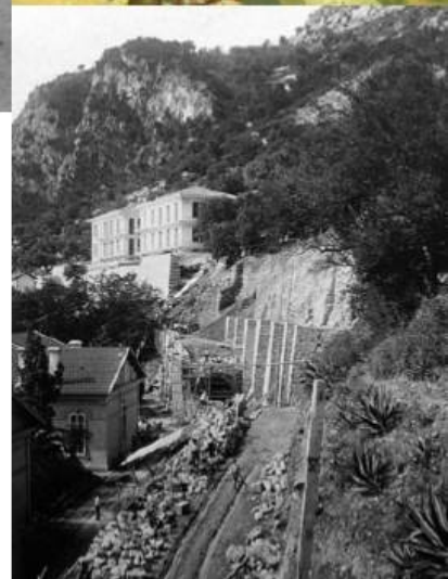
Travaux de l'Hôpital en contresbas de l'Ecole d'Infirmières
